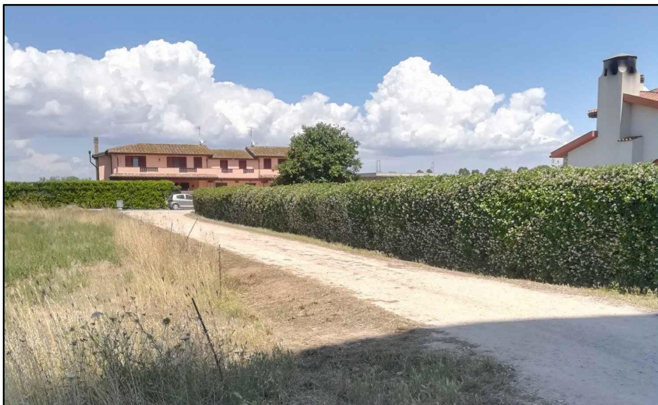
FOTO - N.3 (Accesso esistente all'area P.d.L. del sub comparto A del Piano Quadro)
