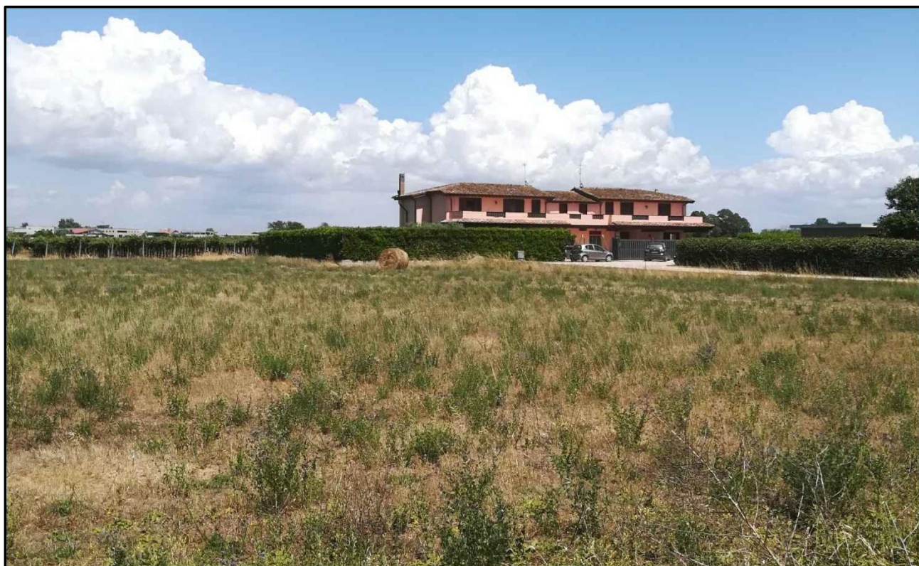
FOTO - N.1 (Angolo nord P.d.L. del sub comparto A-delimitazione sottozona C3 di P.R.G.)
