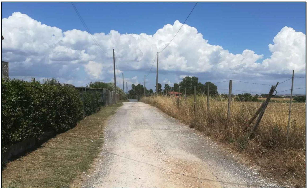
FOTO - N.6 Strada privata sul confine sud del P.d.L. (accesso sub comparto B del Piano Quadro)
