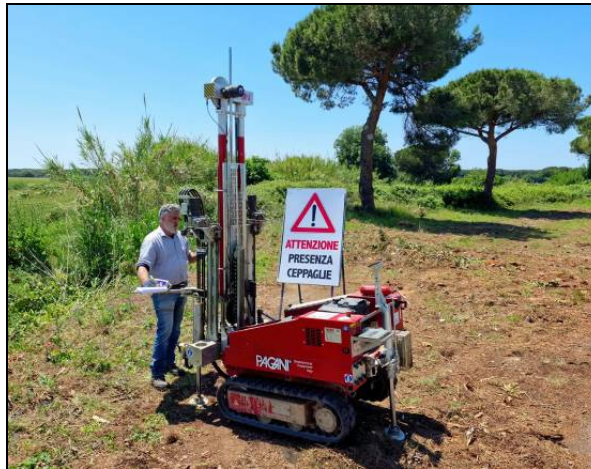
Realizzazione sondaggio penetrometrico S3
