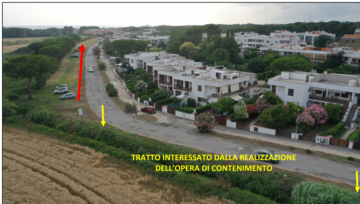
Vista complessiva dell'area di intervento. Nella freccia rossa il proseguo della pista ciclabile
